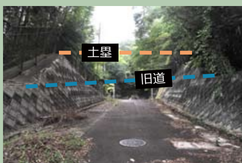
土塁と旧道を切通して施設された水道施設管理道路
